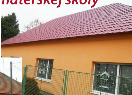
Budova MŠ s novou strešnou krytinou Foto: M. Miháľová
