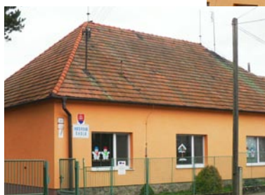
Budova MŠ pred výmenou strešnej krytiny
